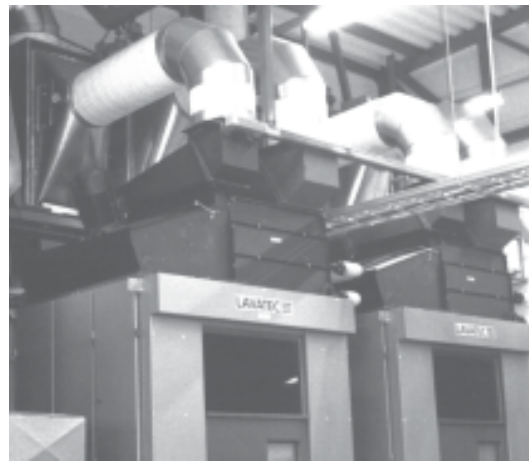
Vaihtopalvelu Oy: 4 kpl roottoreita, sisäasennus 4 pieces Rotary exchangers, mounted inside of the room
