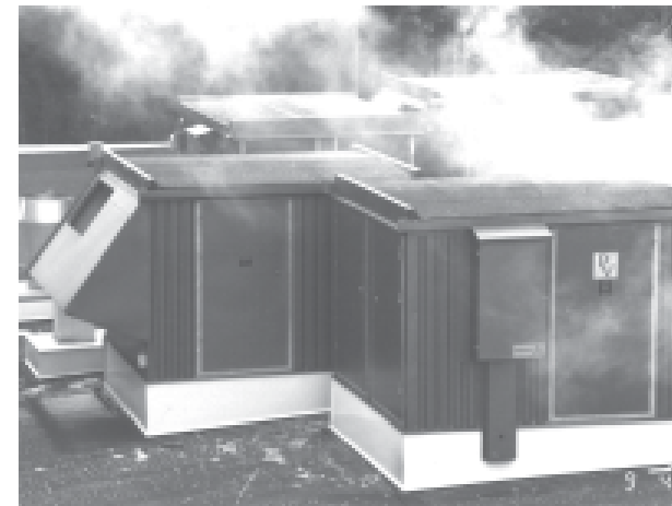
Uudenmaan Sairaalapesula Oy: 8 kpl roottoreita kattokojeissa 8 pieces Rotary exchangers in rooftop units
